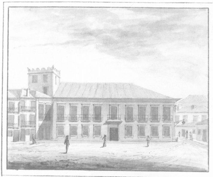
Casa Balsemão, Porto, 1833 (antigo Largo dos Ferradores, actual Praça de Carlos Alberto). Fonte: BPMP
